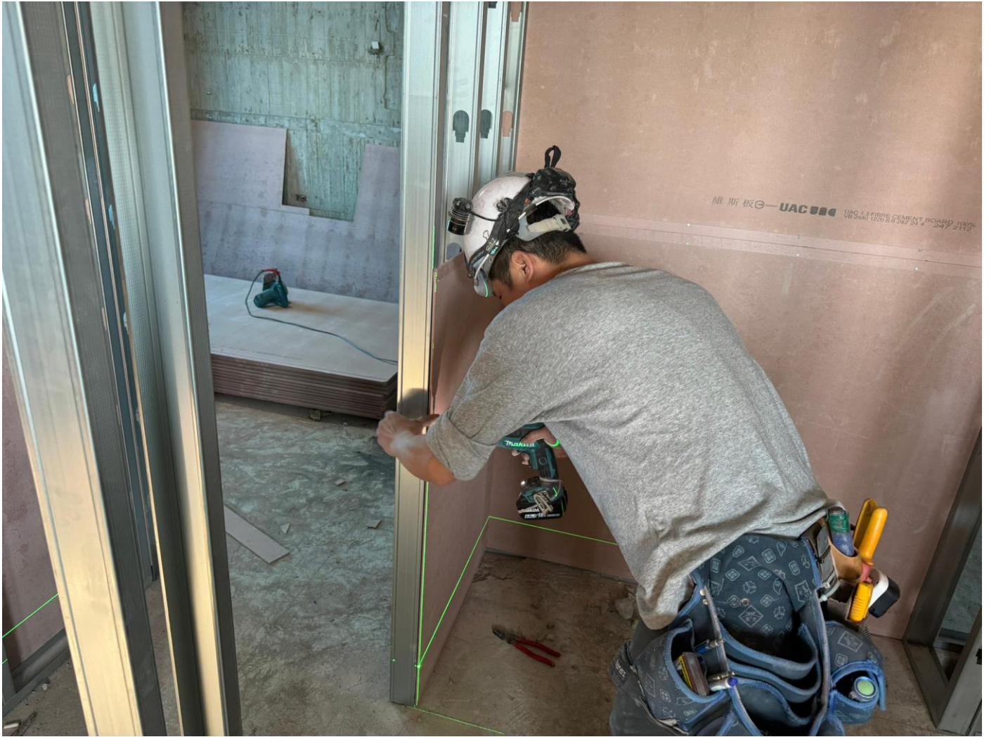
1~14F 輕隔間施作 114.03.22
