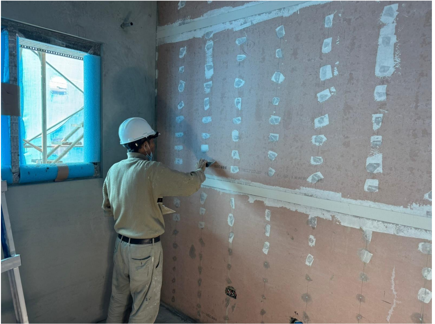
1~14F 輕隔間施作 114.03.22
